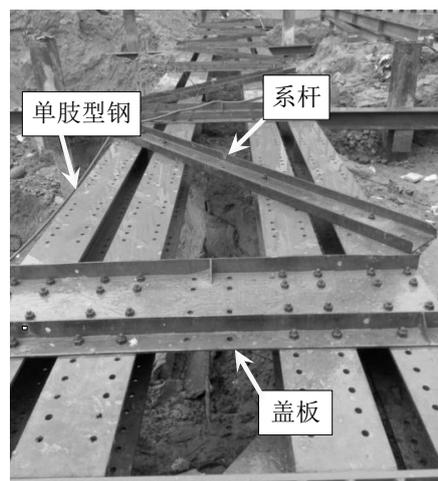
图 7 盖板、系杆的现场照片
