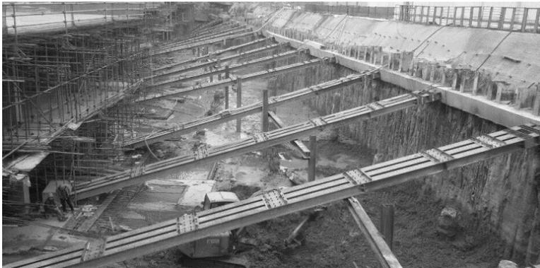
图 9 竖向斜撑的现场照片
