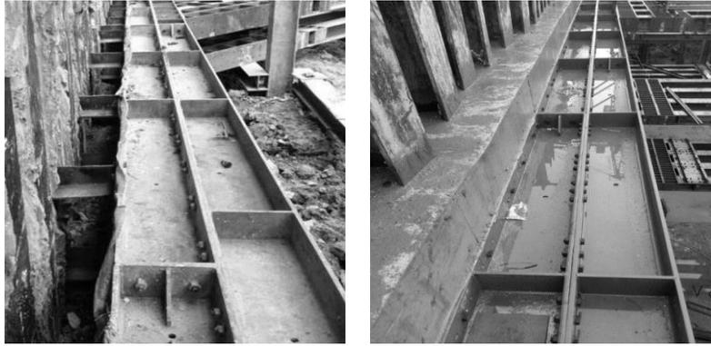
(a) 型钢组合围檩      (b) 型钢-混凝土组合围檩
