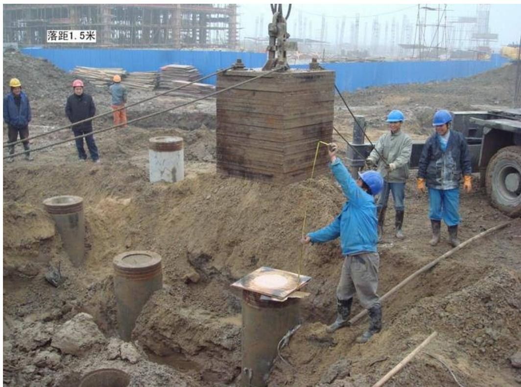
锤重应  $>$  预估单桩极限承载力的 **1.0%~1.5%**，桩径  $>$  **600mm** 或桩  $>$  **30m** 时取高值，落距 **1.5m**。
