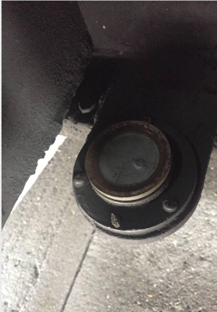
安装于履吊主机台车上的水平仪
